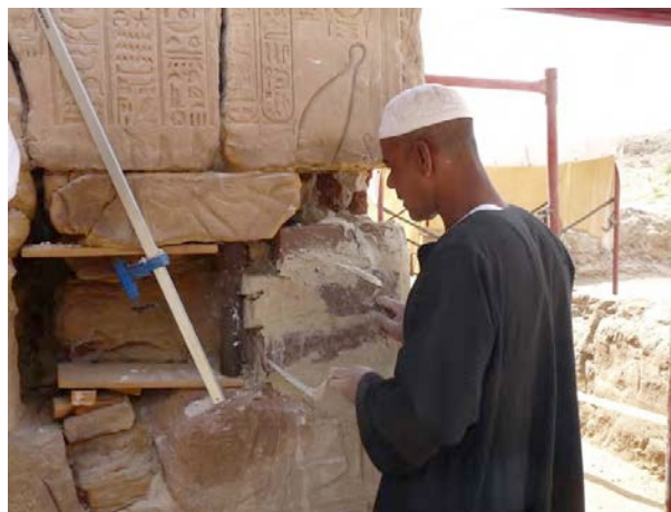
Figure 9. Ragréage en moellons de grès et chaux hydraulique importée ©Cnrs-Cfeetk /L. Pieri.
