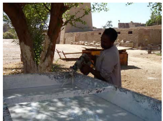
Figure 12. Fabrication de chaux en pâte sur site, malaxage © Cnrs-Cfeetk /L. Pieri.
