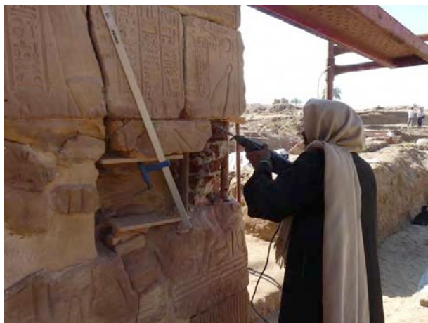
Figure 8. Elimination des anciens ragréages et ciment ©Cnrs-Cfeetk /L. Pieri.
