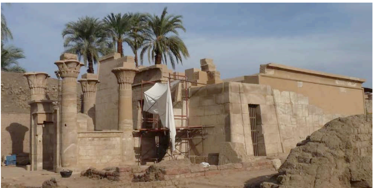
Figure 16. Vue générale après réalisation des enduits de finition © Cnrs-Cfeetk /L. Pieri.
